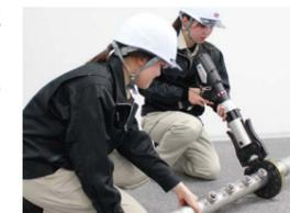
■SP-JOINTの構造、圧着工具
