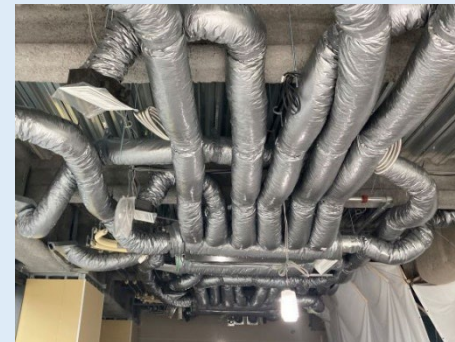
分岐ダクト施工
