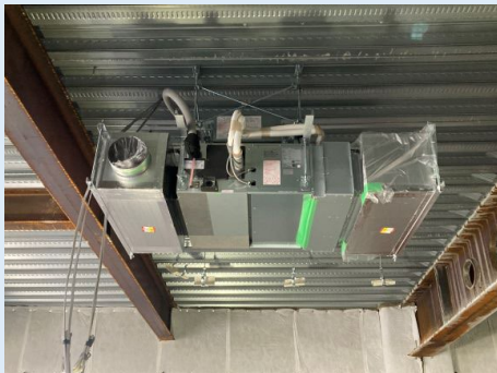
現場据付状況
