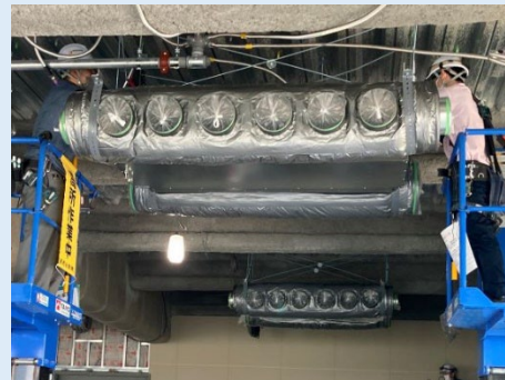
現場据付状況
