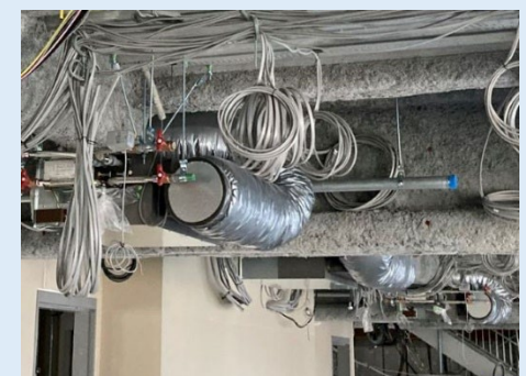
現場据付状況
