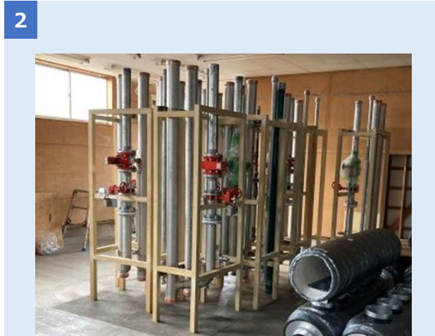
工場仮置状況
