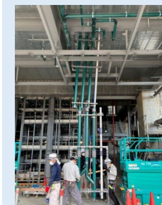
現場据付状況
