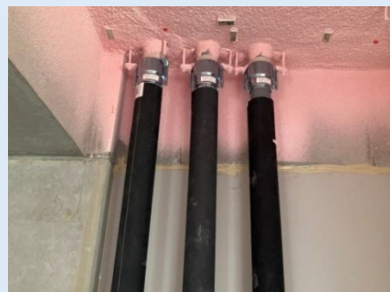
現場取付状況
